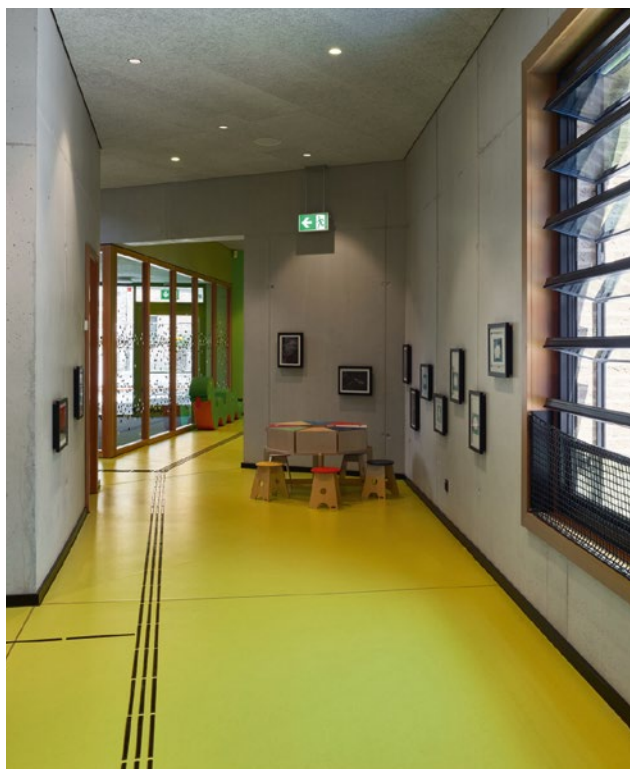
Bildbeschreibung: Das Leitsystem am Fußboden im FRÖBEL-Kindergarten FröbelBANde.
